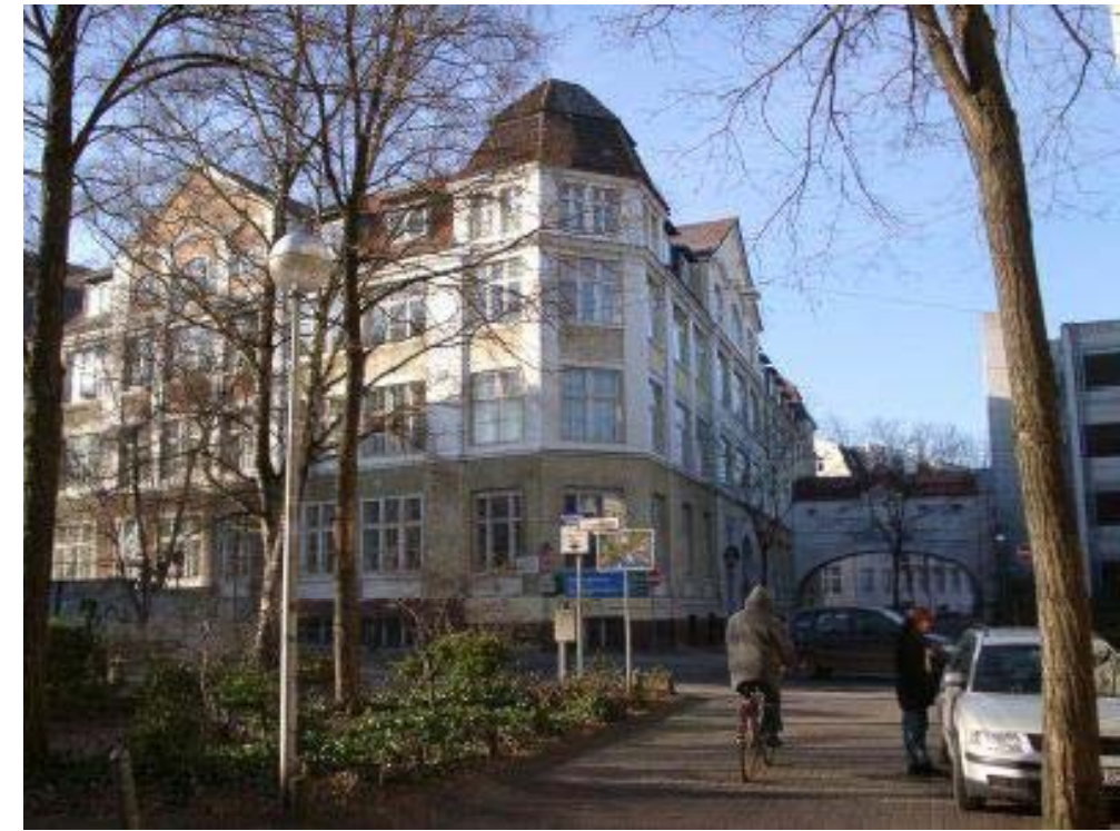
Dienstgebäude in der Ravensberger Straße 12
